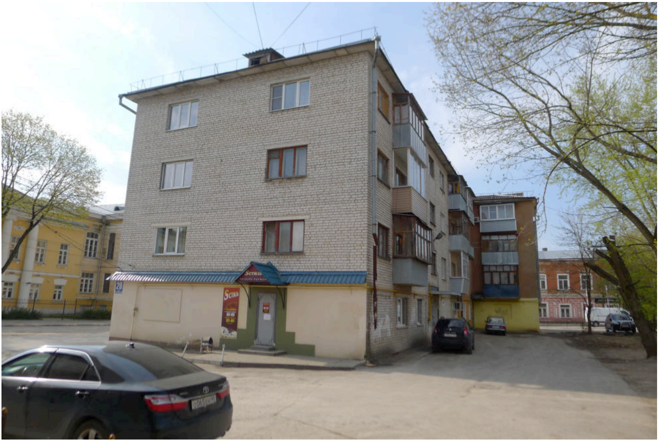
Фото 7. Вид с северо-запада.
