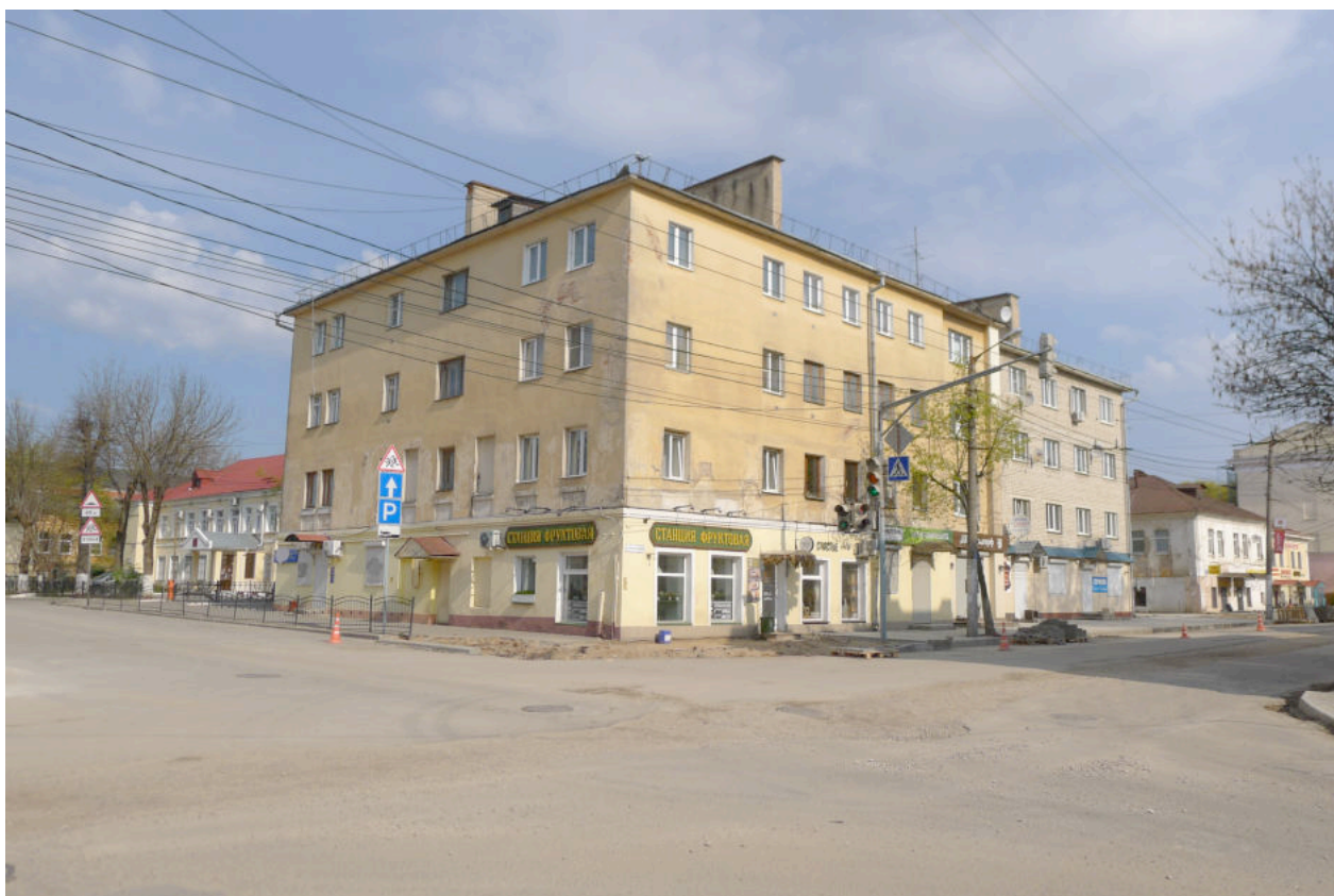
Фото 2. Вид дома с юго-востока.
