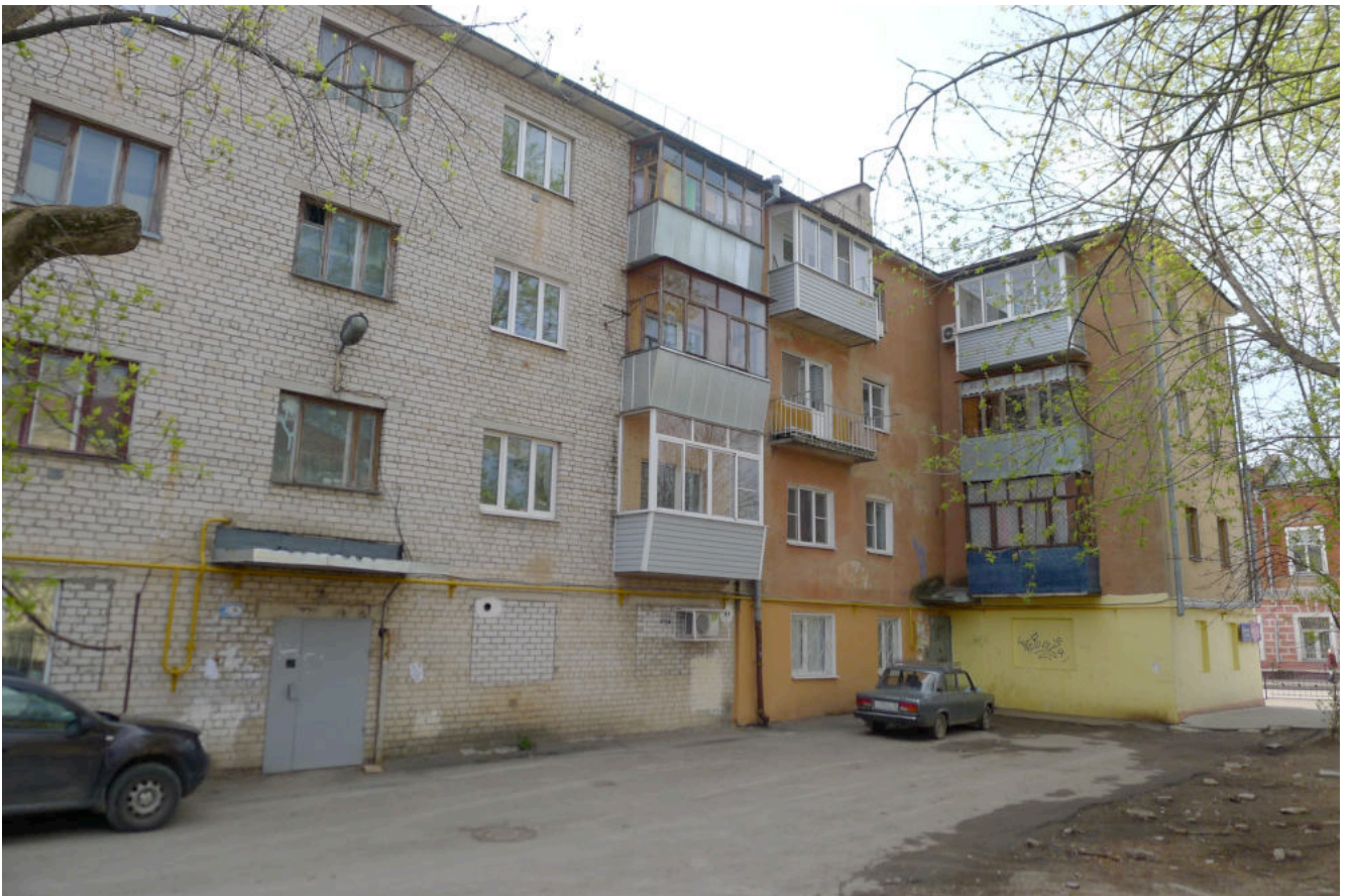
Фото 6. Вид с северо-запада.
