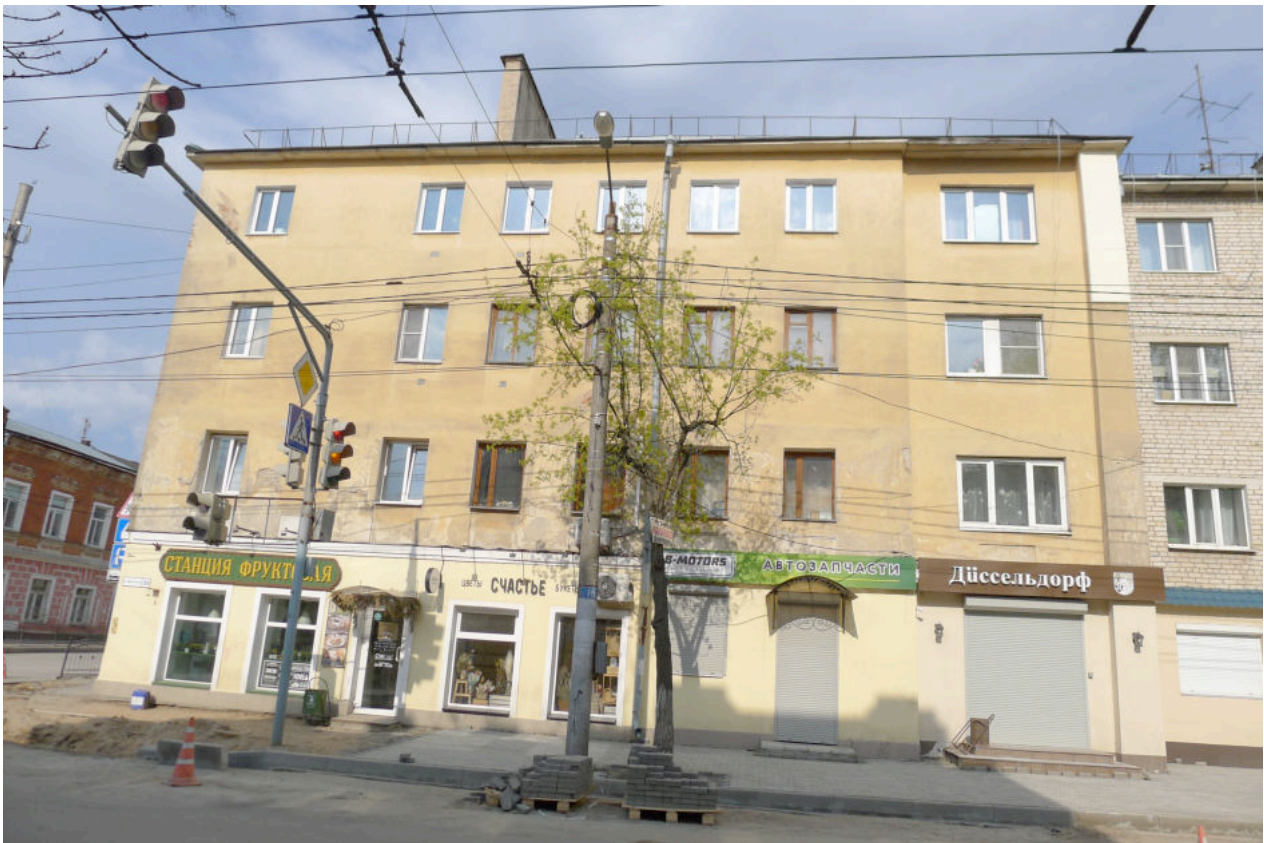
Фото 3. Восточный фасад. К первоначальному объему относится стена с 7 осями проемов, окна на 2-й оси слева заложены.
