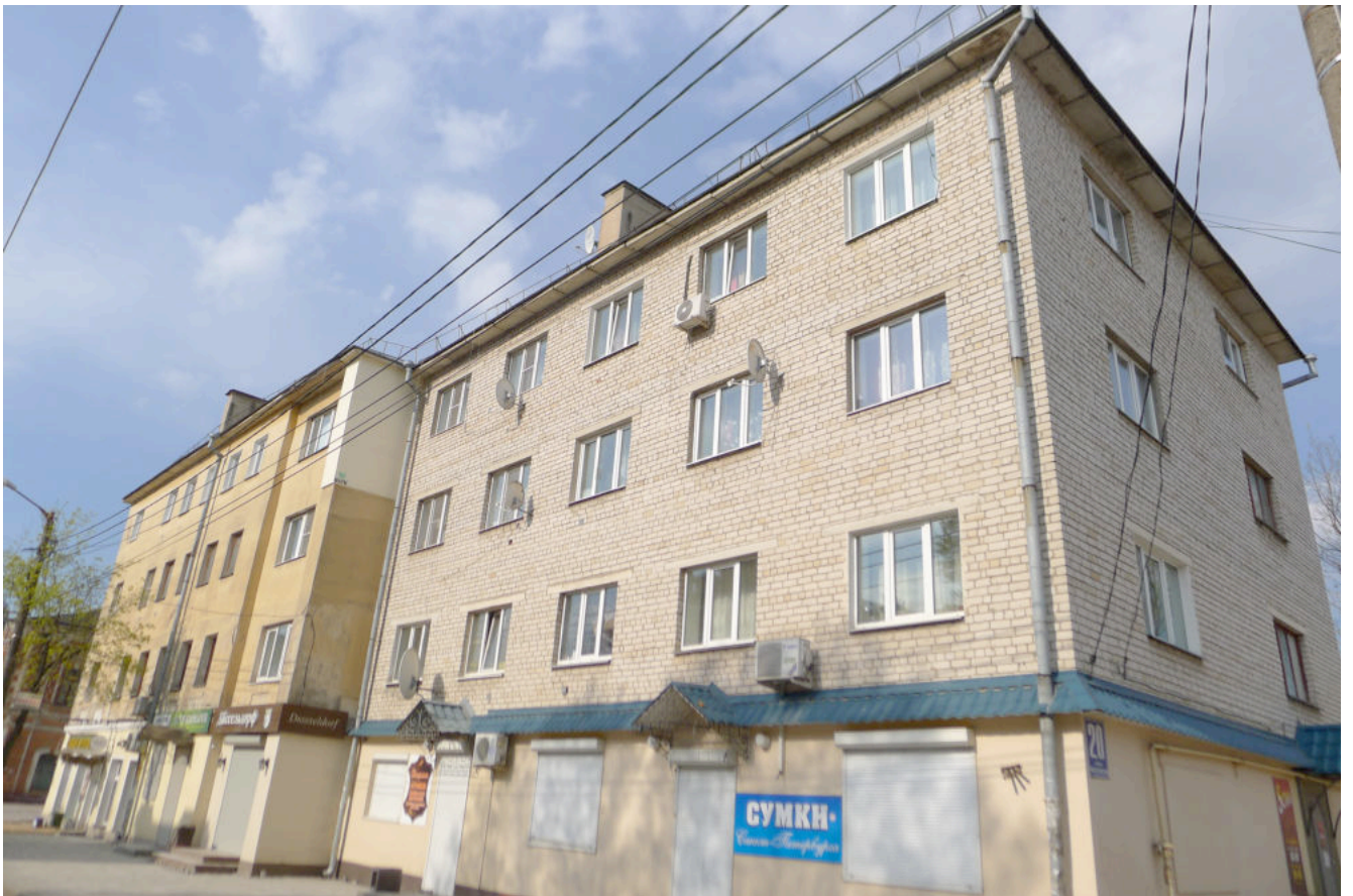
Фото 8. Вид с северо-востока.
